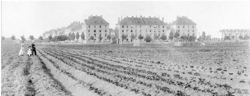
Blick auf die Wohnanlage Aindorferstrasse
